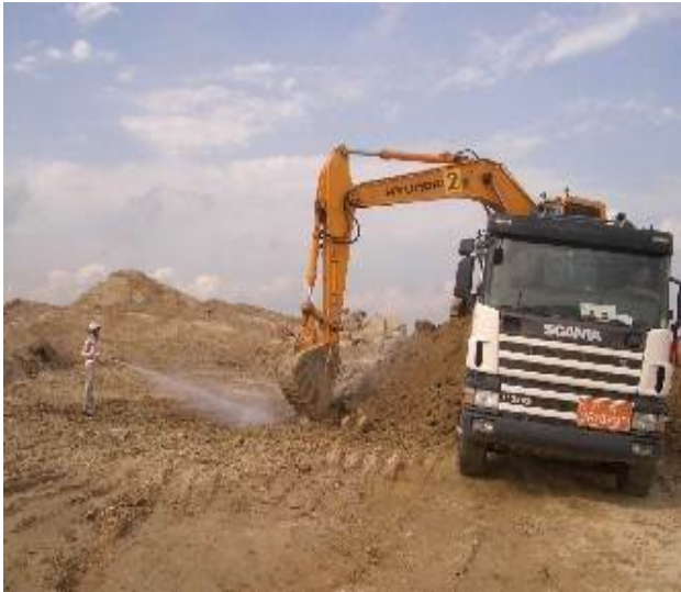
토사 등의 신기 및 내리기 작업시 고정식 또는 이동식 살수시설 설치운영
