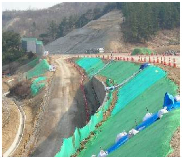
도로공사의 토사법면에 방진덮개 설치
