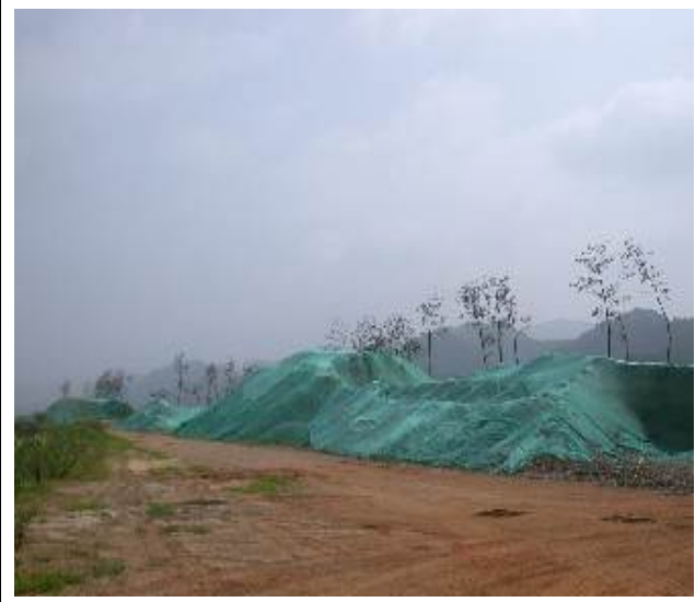
야적토사에 방진덮개 설치
